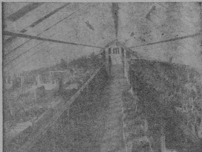
Los cultivadores utilizan extensamente el Dexion en la construcción de invernáculos, puesto que pone a su alcance el medio de montar estructuras 'hechas a medida' a un precio económico. No sufre deterioro como la madera y puede volverse a emplear para nuevas instalaciones.
