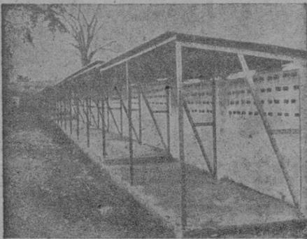
Los sencillos bastidores para cobertizos, como los empleados en estos establos para ganado, pueden construirse fácilmente con Angulo Ranurado Dexion. En las instalaciones ilustradas se emplea material Dexion 225/S y tejado de chapas de acero ondulado.
