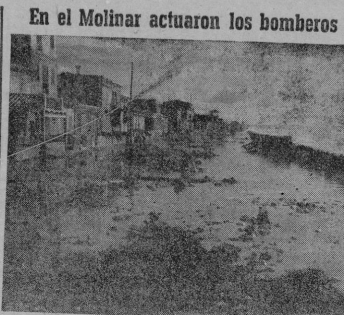
En el Molinar actuaron los bomberos A causa del reciente temporal, la zona de Levante se vió nuevamente castigada por las olas. En el Molinar el oleaje rompió parte de uno de los muros de contención. A causa de haberse obturado las «ventanillas de desagüe» de la escollera se almacenó gran cantidad de agua en la parte de tierra, y fue precisa la intervención de los Bomberos para abrir dichas ventanillas. En la foto puede apreciarse como el agua alcanzó hasta las primeras casas de la popular barriada.
