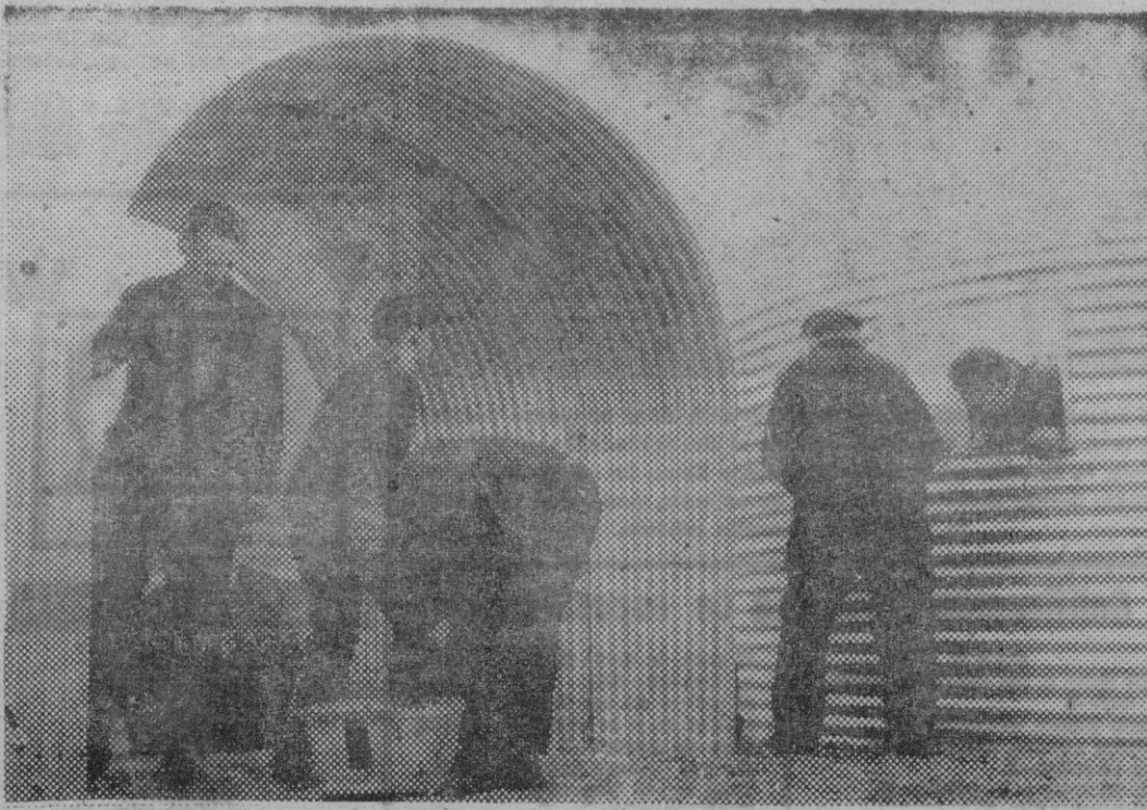
En París, donde tiene lugar el Concurso General Agrícola, se muestran los últimos adelantos en la materia, sobre todo en lo que se refiere a la maquinaria para el campo. En la foto vemos elementos de chapa ondulada para los silos y cobertizos. El material ofrece la ventaja de montarse y desmontarse con facilidad.—(Foto Pyresa)
