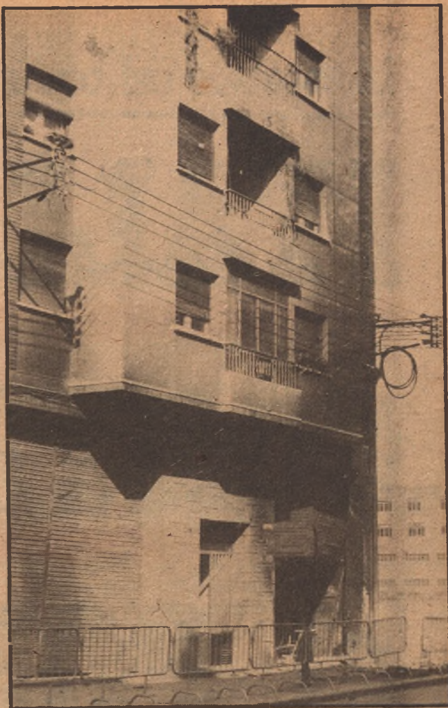
Este es el edificio número 45 de la calle Rodrigo Rebolledo, que, juntamente con las fincas números 41 y 43, fueron escenario de un trágico incendio el 11 de diciembre de 1973. Más de ocho meses después del suceso, van a iniciarse las obras de reparación.
