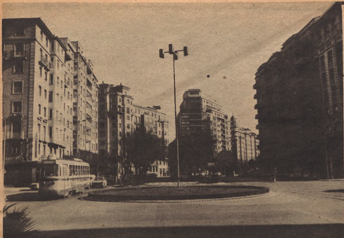
Esta es la plaza sin nombre, en la confluencia de la Avenida de Goya, y los Paseos de Calvo Sotelo y Fernando el Católico. ¿Por qué no instalar aquí la fuente que hoy funciona irregularmente en la Plaza del Paraíso?
