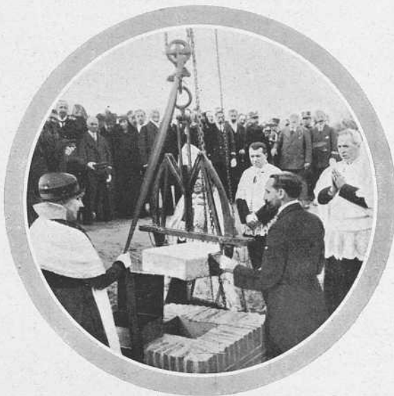
Su Majestad la Reina colocando la primera piedra del sanatorio de Valdelatas. Fot. Marín y Ortiz.
