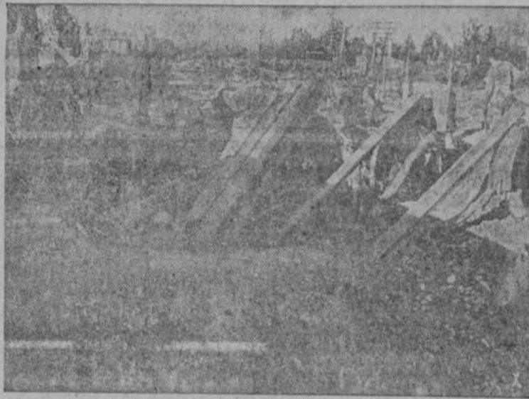
Instalaciones ferroviarias de un sector de San Petersburgo, destruidas por los Stukas alemanes.
