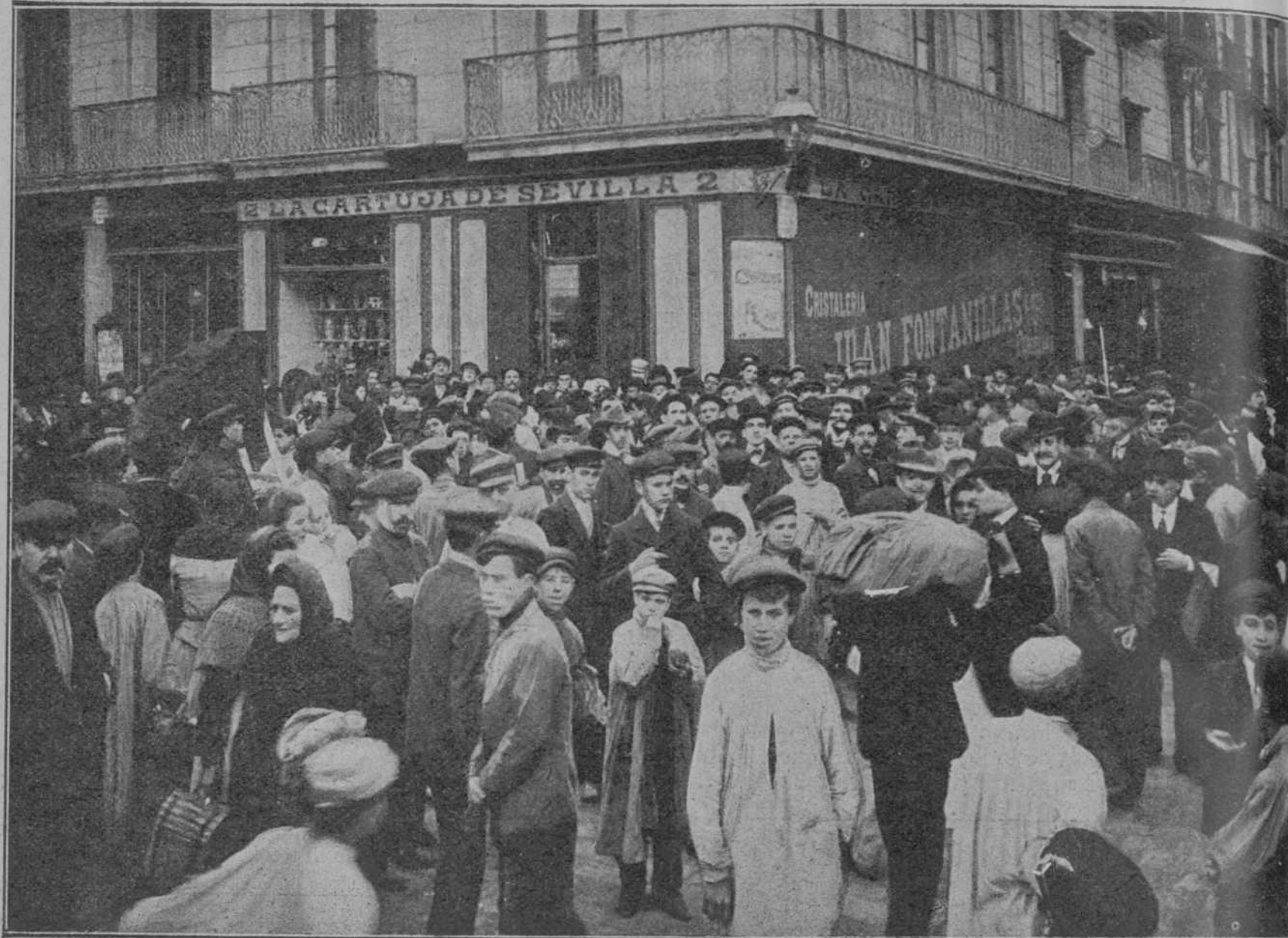
La cantonada de La Cartuja, lloch ahont explotá la bomba.
