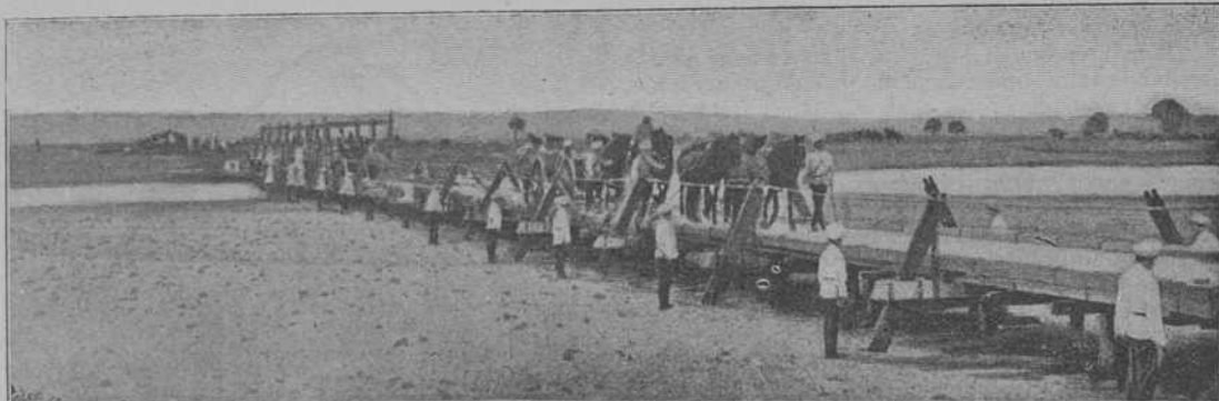
Un destacament de soldats russos, probant la resistència d' un pont construït sobre 'l Yalu (frontera coreana).
