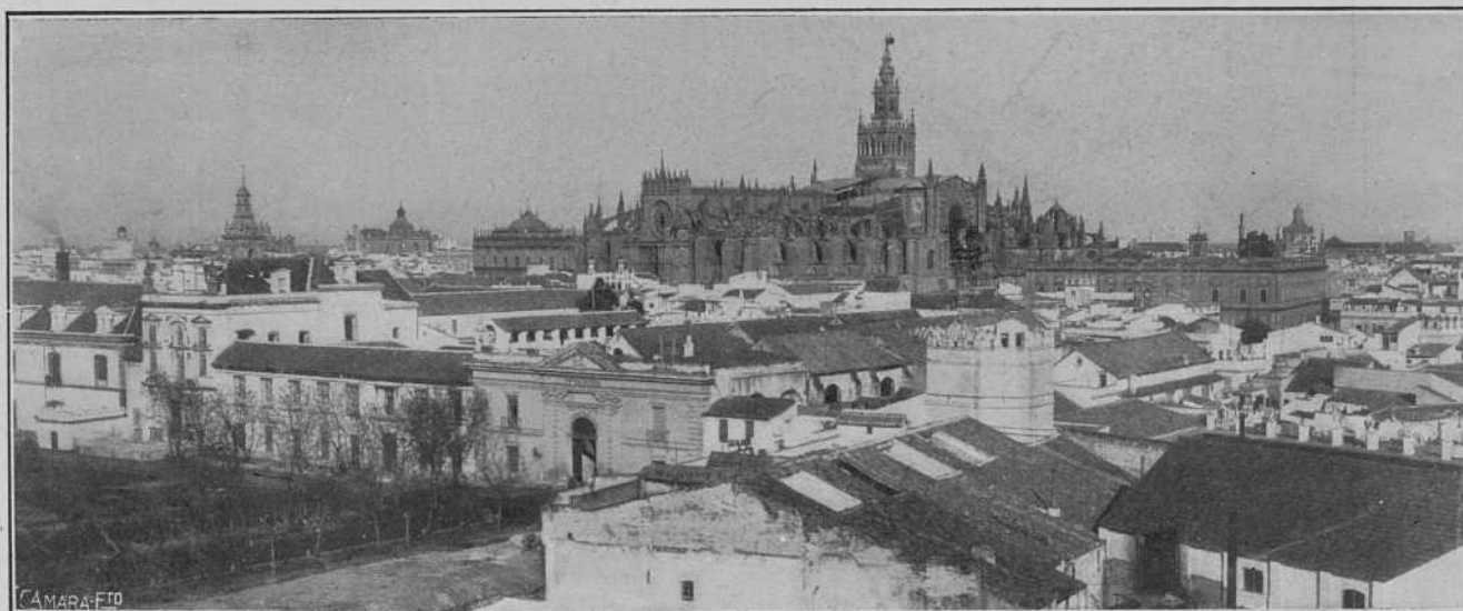
Sevilla.—Vista de la Catedral desde la Torre del Oro
