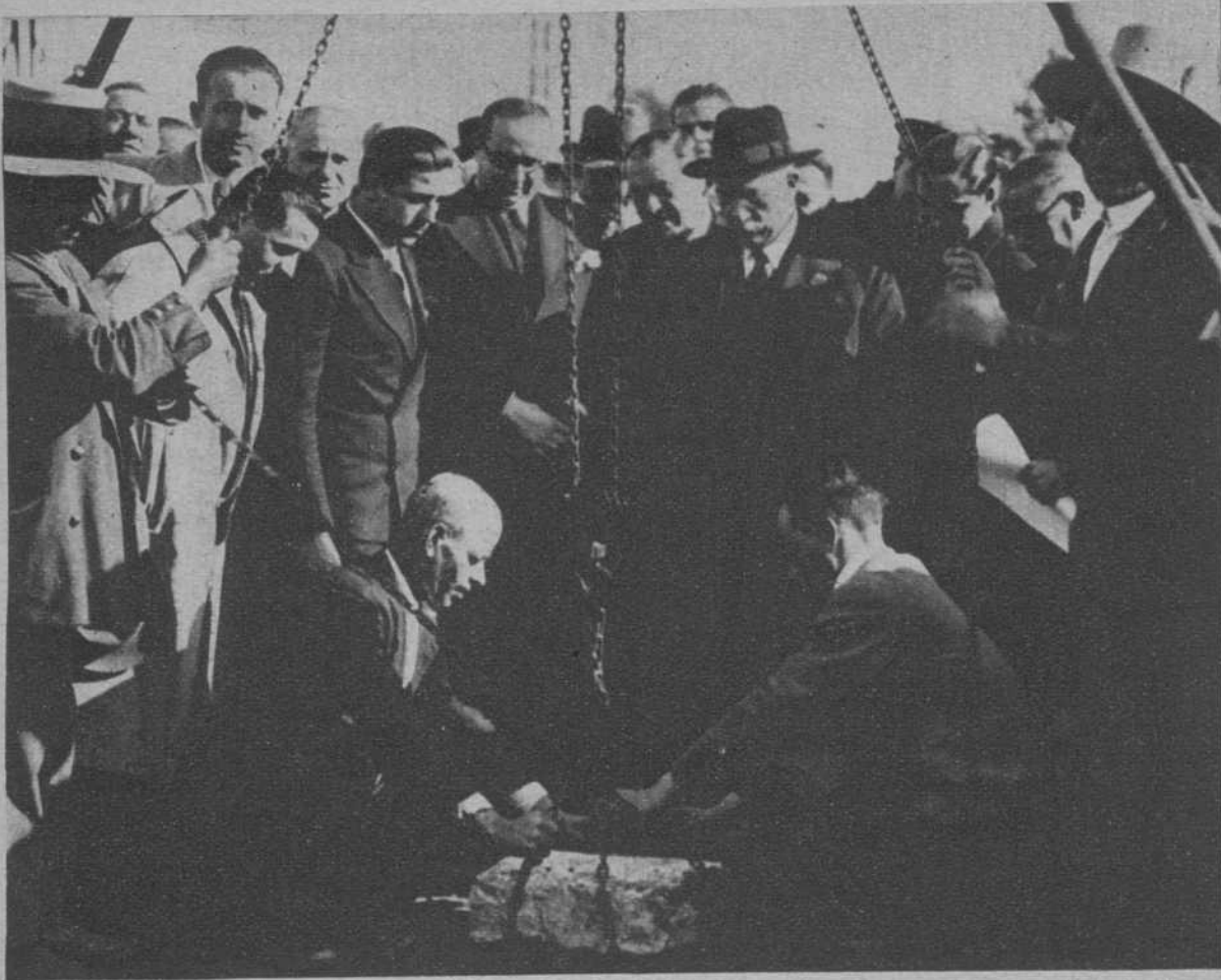
El señor Lerroux en la colocación de la primera piedra de la barriada obrera, en la antigua Huerta de Santa Teresa.—(Fot. Sánchez del Pando)
