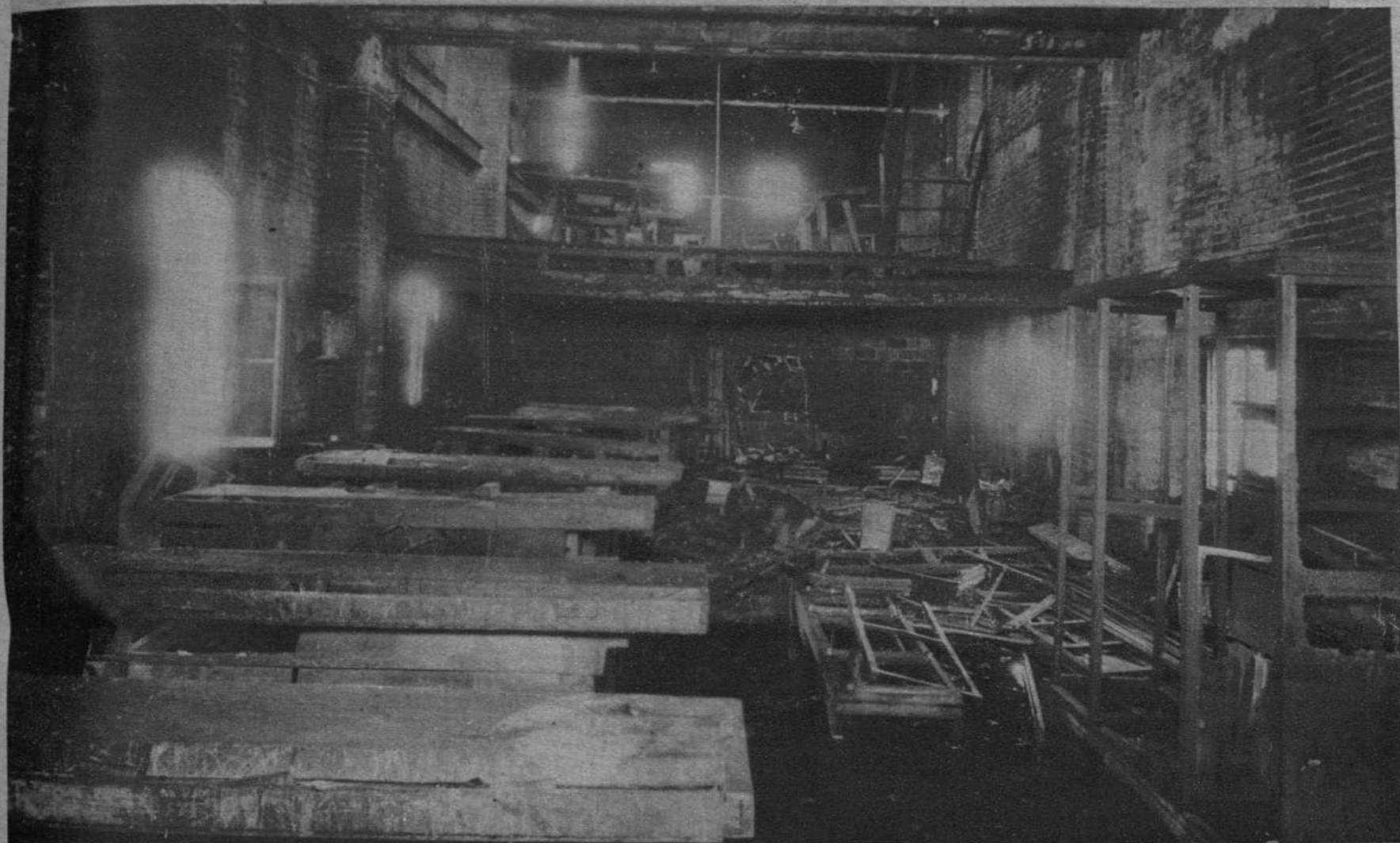
El taller de muebles, establecido en la calle de Francia, que se incendió la noche del viernes.—(Fot. Merletti)
