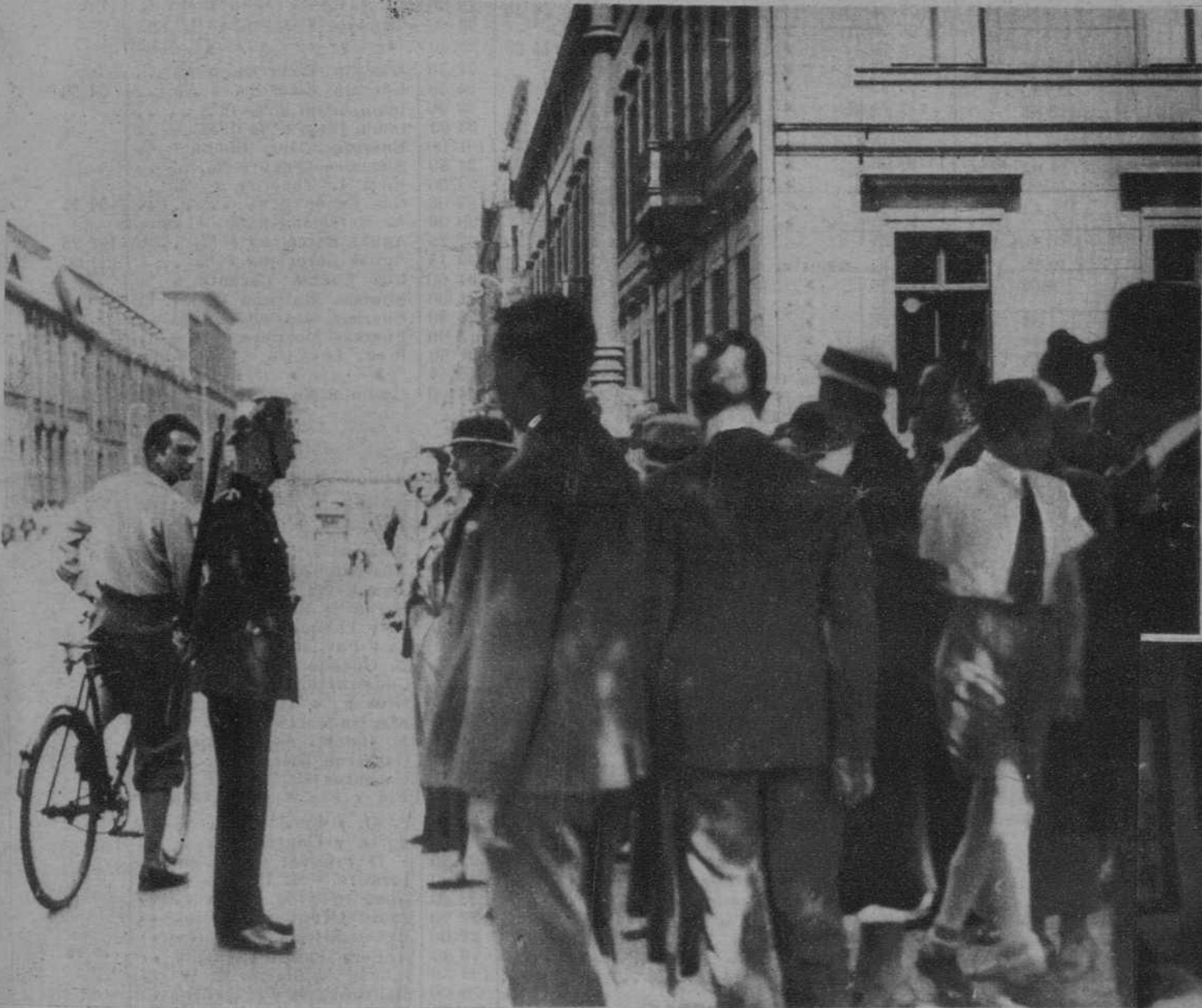
Berlin.—Curiosos estacionados frente al edificio de la Cancillería. (Foto Keystone)
