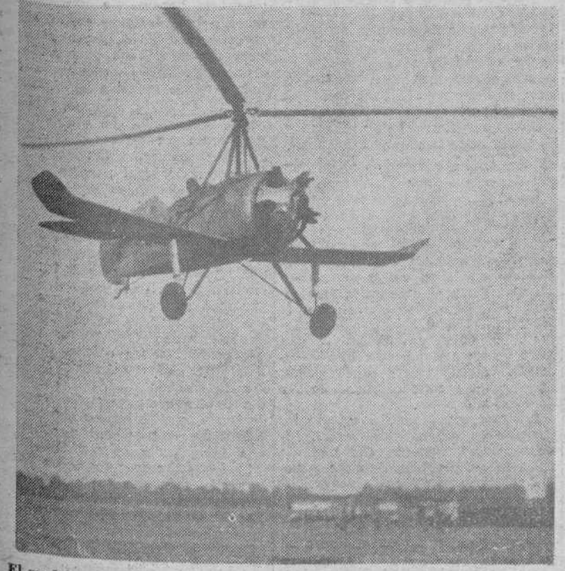
El modelo de autogiro con alas, ya en desuso. Avioneta-autogiro La Cierva propiedad del ex marqués de las Pressas, evolucionando sobre el campo de Tablada (Fot. Archivo "Publicaciones Gráficas, S. A.")
