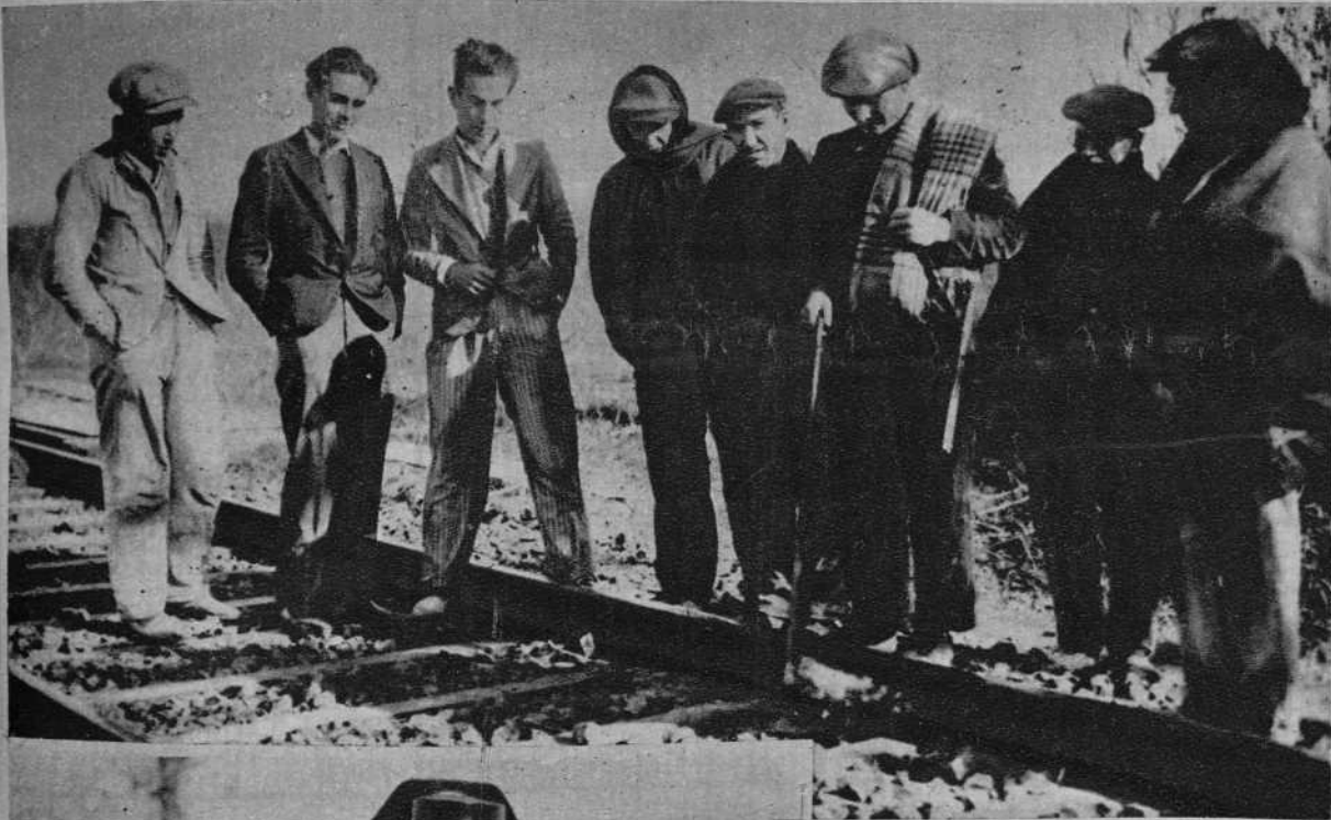
También en la vía férrea del Central de Aragón, intentó cometerse otra salvajada parecida a la del rápido Barcelona-Sevilla, colocando dos bombas. Un guarda de término, señala el lugar en que estalló una de ellas
