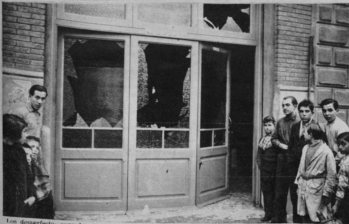
Los desperfectos causados por la explosión de una bomba en «Industrias Gráficas», de la calle de Enna (Fot. Pérez de Rozas)
