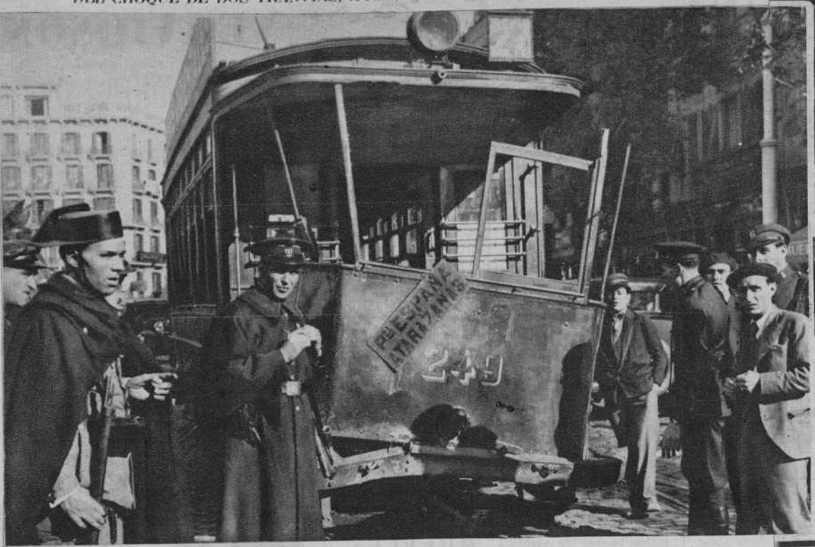
Estado en que quedó el coche de la línea 27
