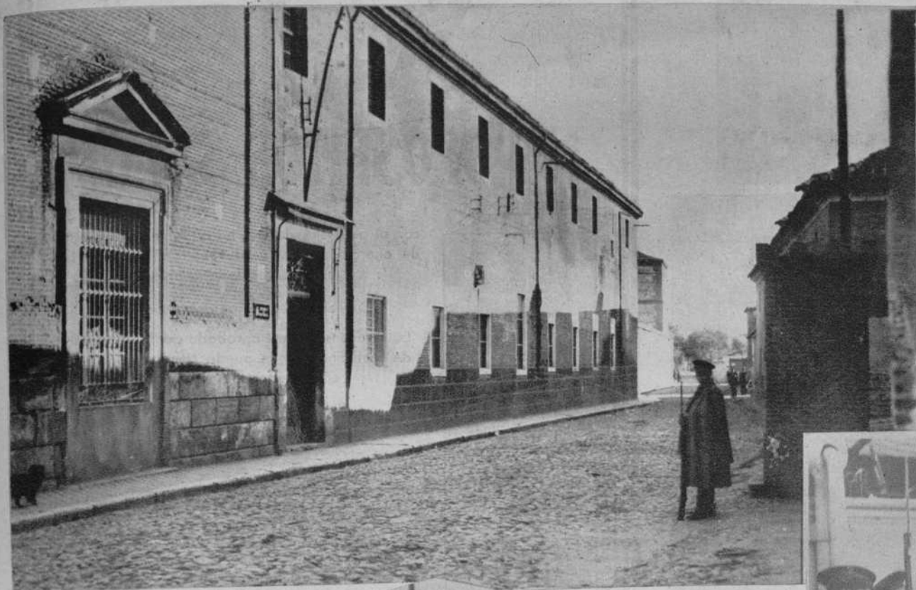
Vista exterior de la cárcel en que estaba detenido el señor March
