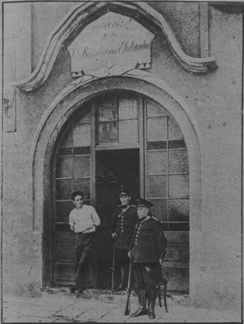
Una subcentral de la Barcelonesa de Electricidad, custodiada por la fuerza pública.—(Fot. Merletti)
