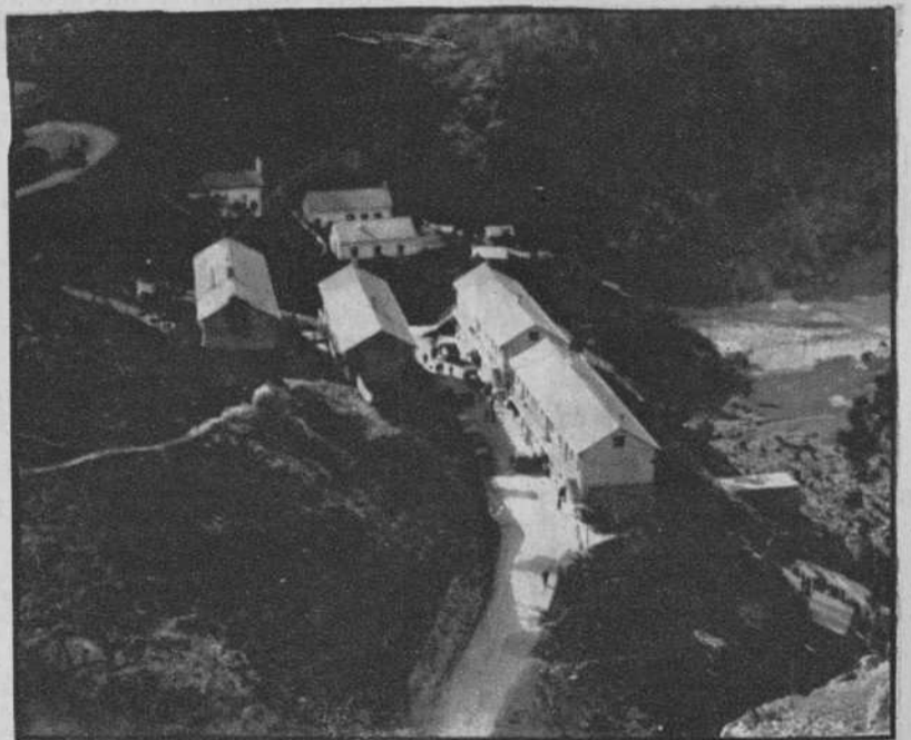
Millares (Valencia).—Vista general del «salto» en que se ha registrado el hundimiento de unas viviendas, al desprenderse un peñasco. — (Fot. Bondía)
