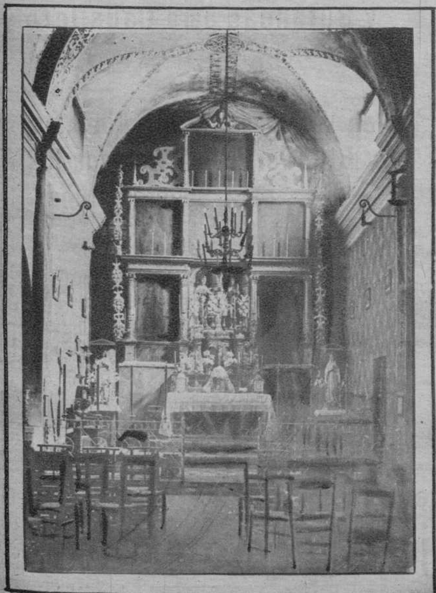
Interior de la iglesia
