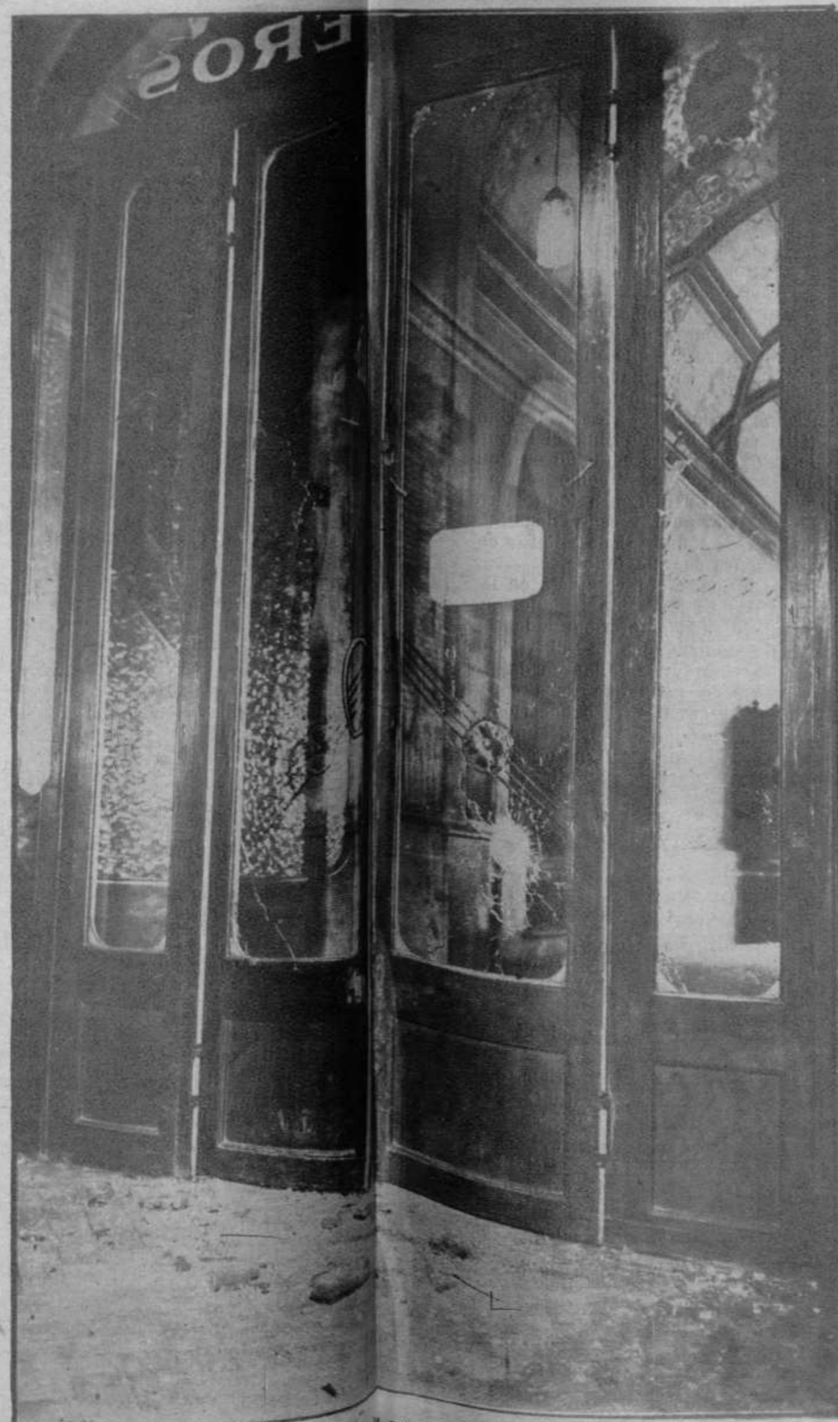
Los desperfectos causados en la puerta de la casa número 30 de la Rambla del Centro a consecuencia del tiroteo
