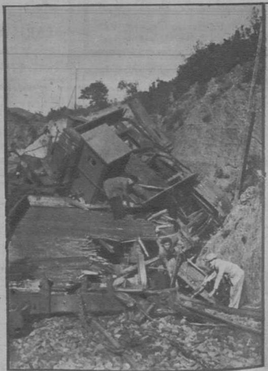
Lugar de la catástrofe, producida por el derrumbamiento de un terraplén. — Fots. Santos
