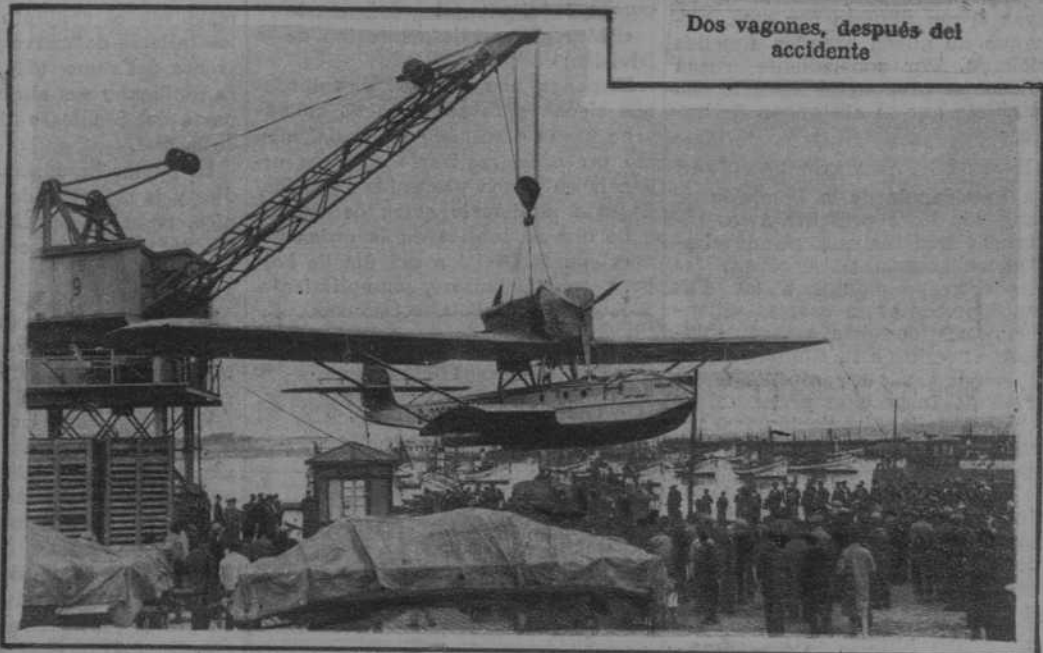
Coruña.—Momento de ser sacado del agua el hidroavión alemán que, por avería en uno de sus motores, cayó al mar en las proximidades del Cabo de Palos, siendo remolcado hasta este puerto. — (Fot. Canelo)
