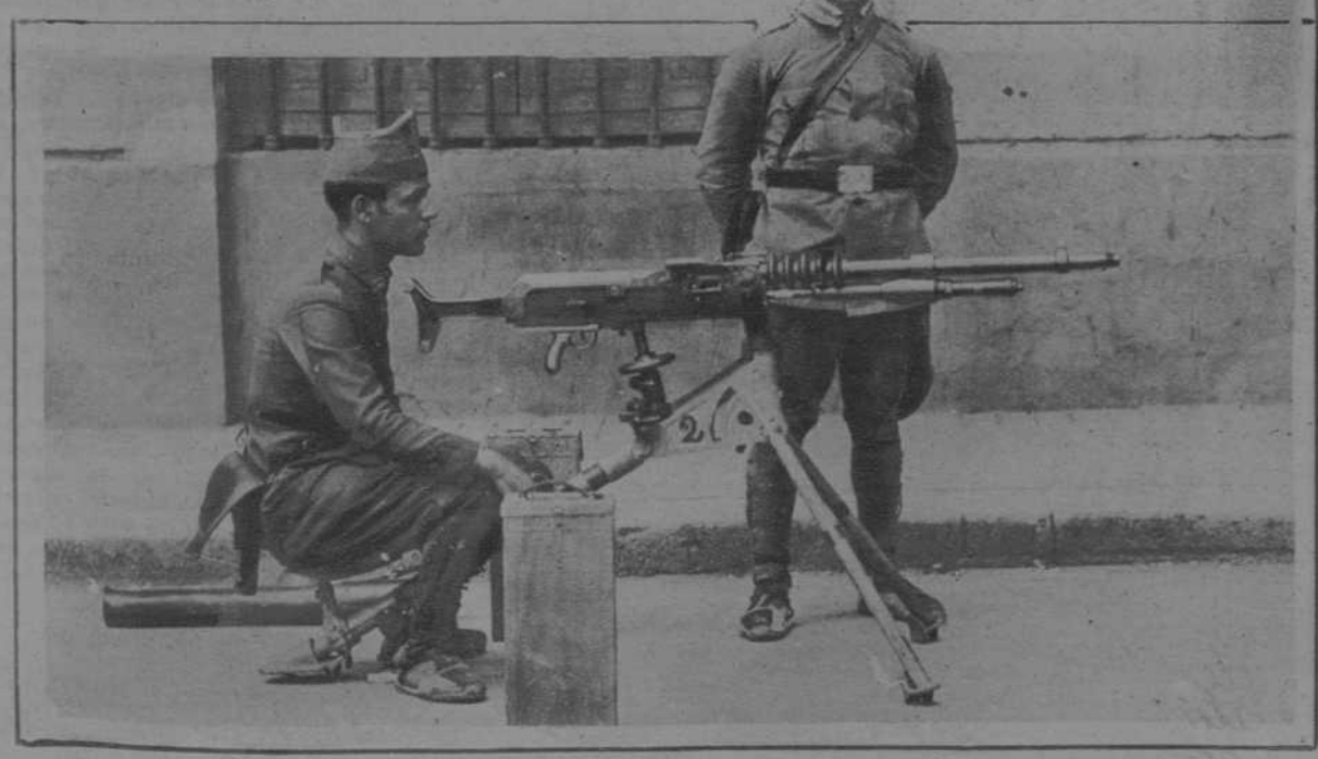
Ametralladora instalada frente al edificio del Ayuntamiento
