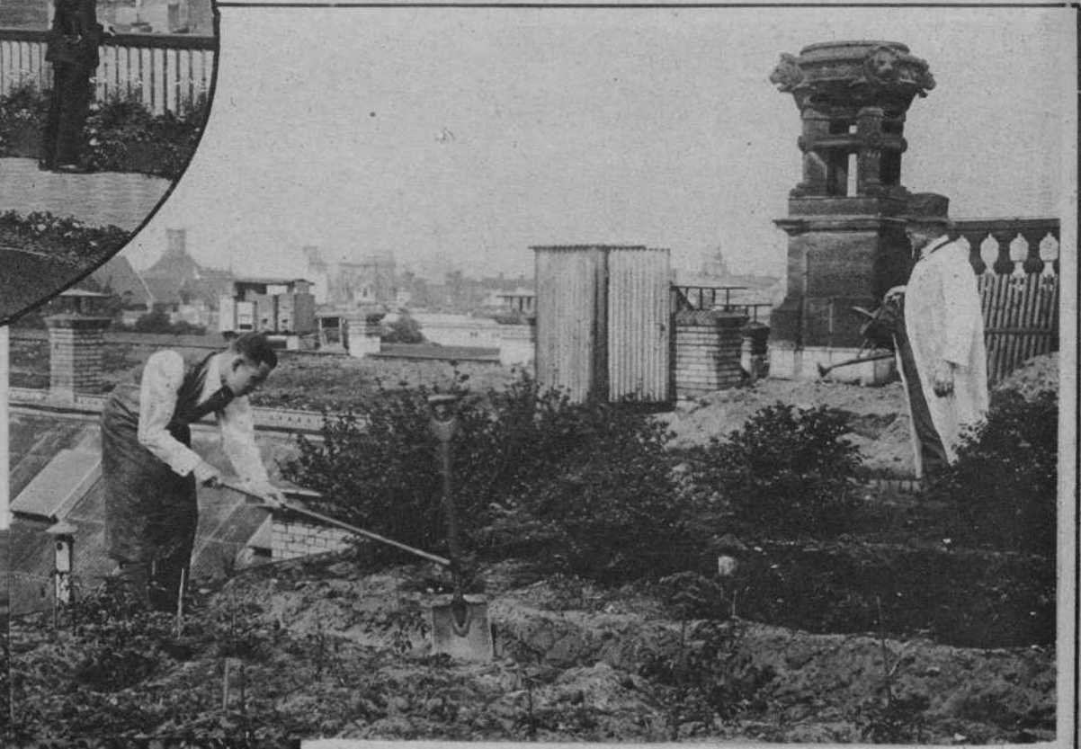
Si no fuera por la barandilla, apenas podría creerse que este «panorama agrícola» está sobre una azotea
