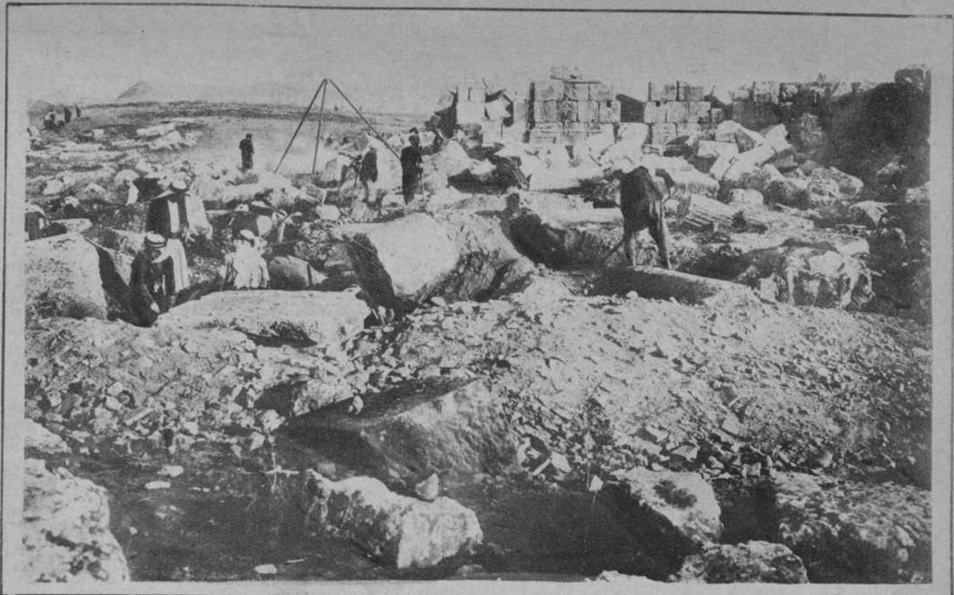
Restos del monumento que, formando un conjunto arquitectónico de más de 200 metros de perímetro, debió estar emplazado en el centro de la ciudad
