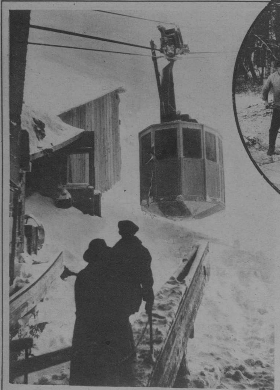
Una derivación colgante del ferrocarril de «Zugspitzbahn»
