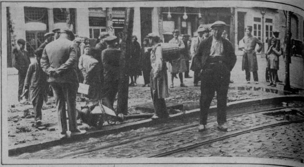
Un curioso accidente callejero. Desperfectos ocasionados, en la Rambla de Cataluña, cruce con la calle de Provenza, por la rotura de una cañería de conducción de agua (Fot. Maymó)
