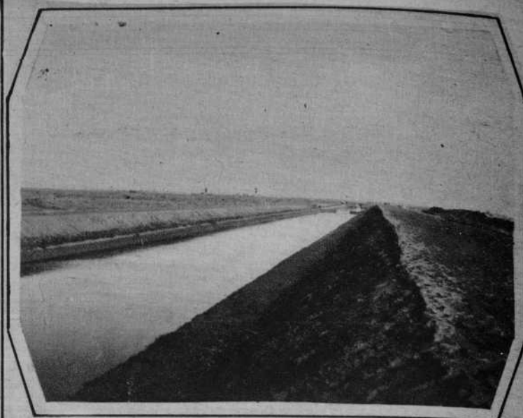
Zanja de desagüe de la propiedad Meruan
