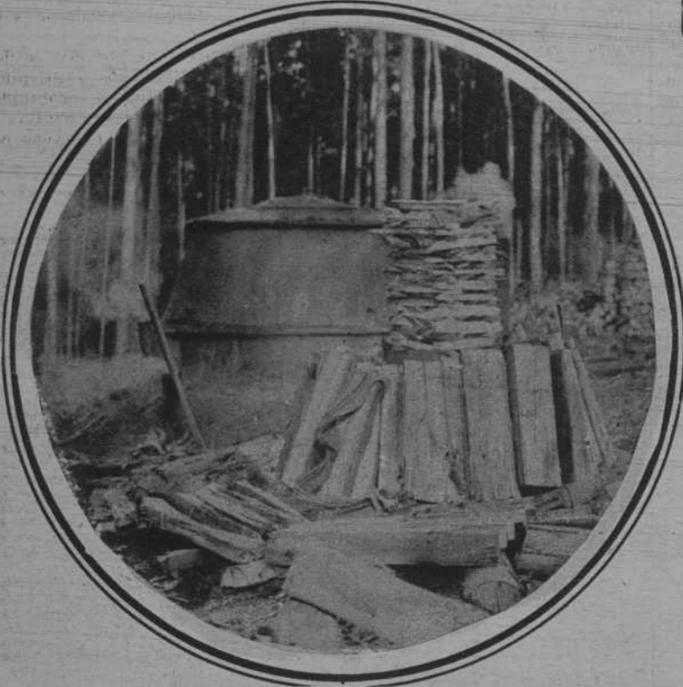
Hornos desmontables y portátiles que a lomo de bestias se conducen a los lugares más abruptos de la montaña
