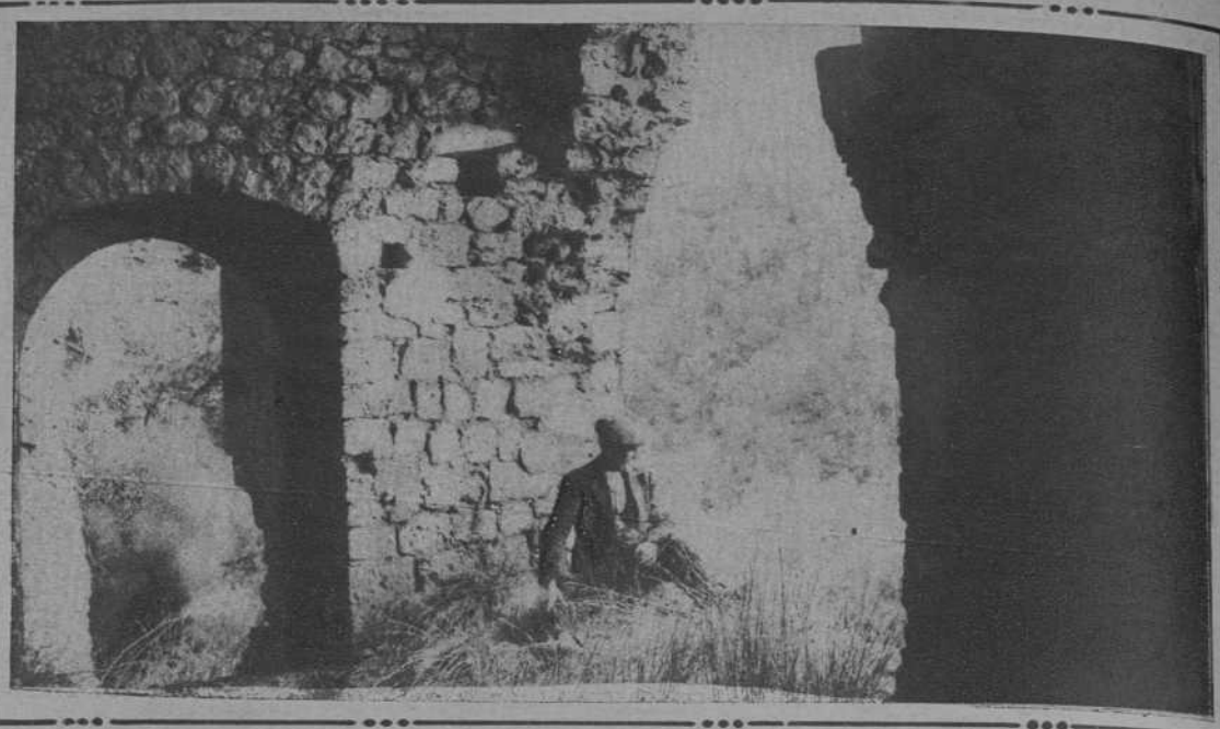
La entrada y ventanal derruidos.
