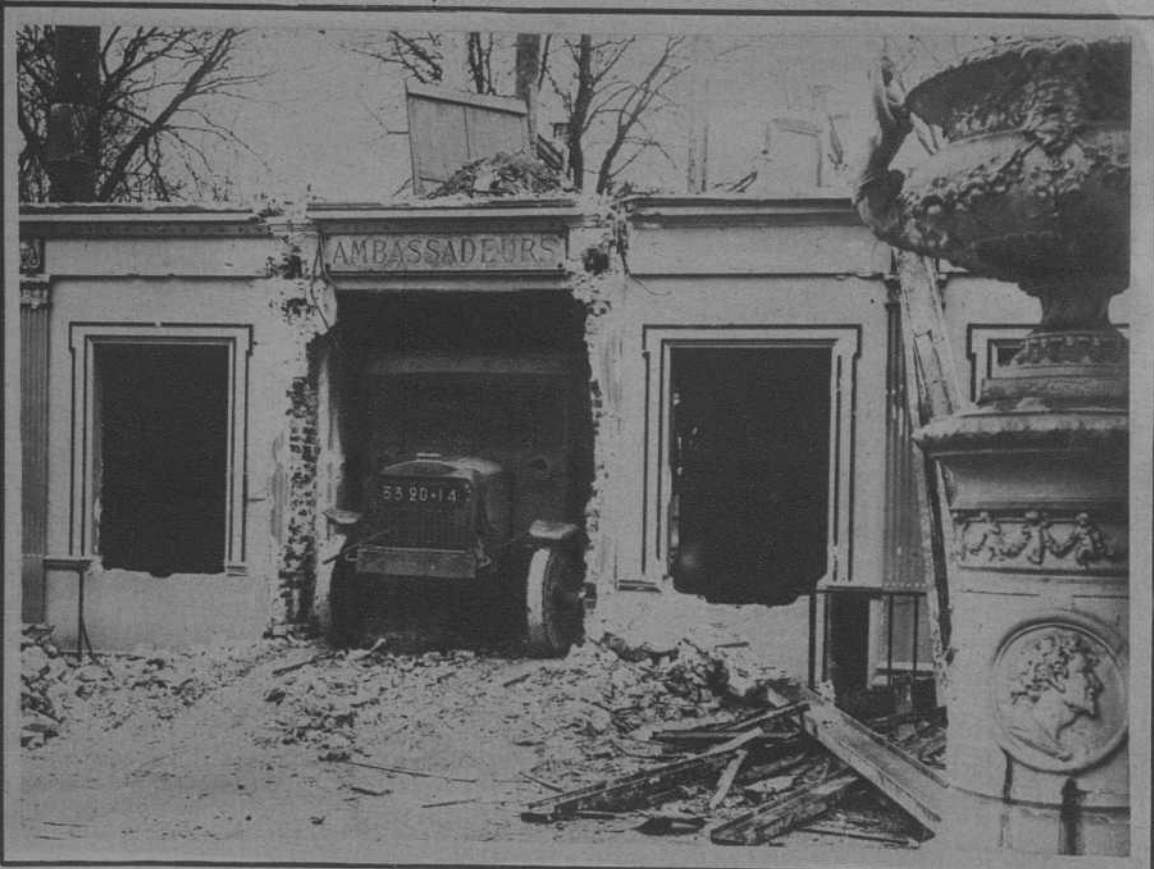
El París típico desaparece. El famoso concierto «Des Ambassadeurs», de los campos Eliseos, donde fueron aplaudidas las más famosas vedettes del music-hall, está siendo destruido. Véase un aspecto del edificio en vías de derribo. — (Fot. Meurisse)
