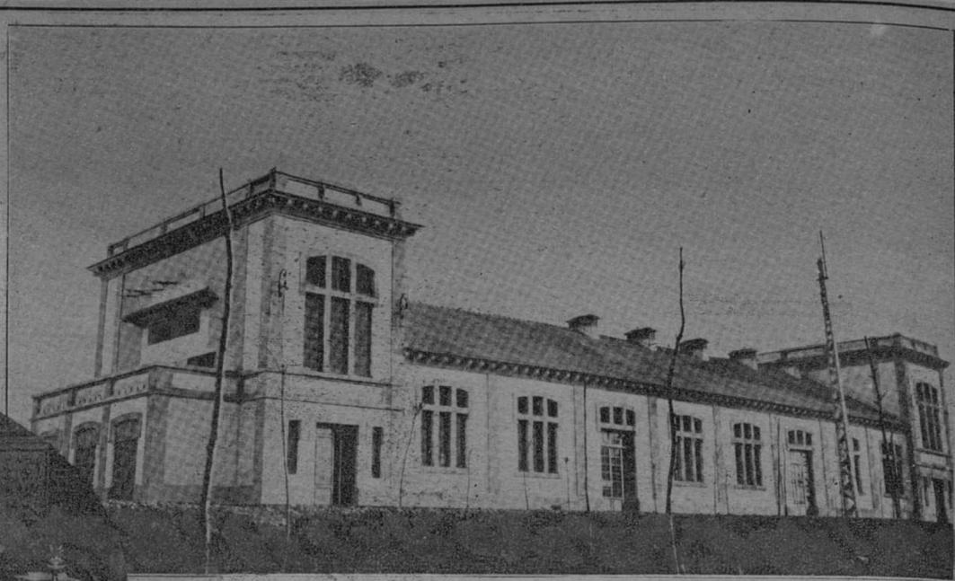
Subestación de Padul, para transformar la corriente alterna a 25.000 voltios. 1.000 kw. instalados con batería de Acumuladores «Tudor», a 1.200 voltios de 500 kw. de potencia
