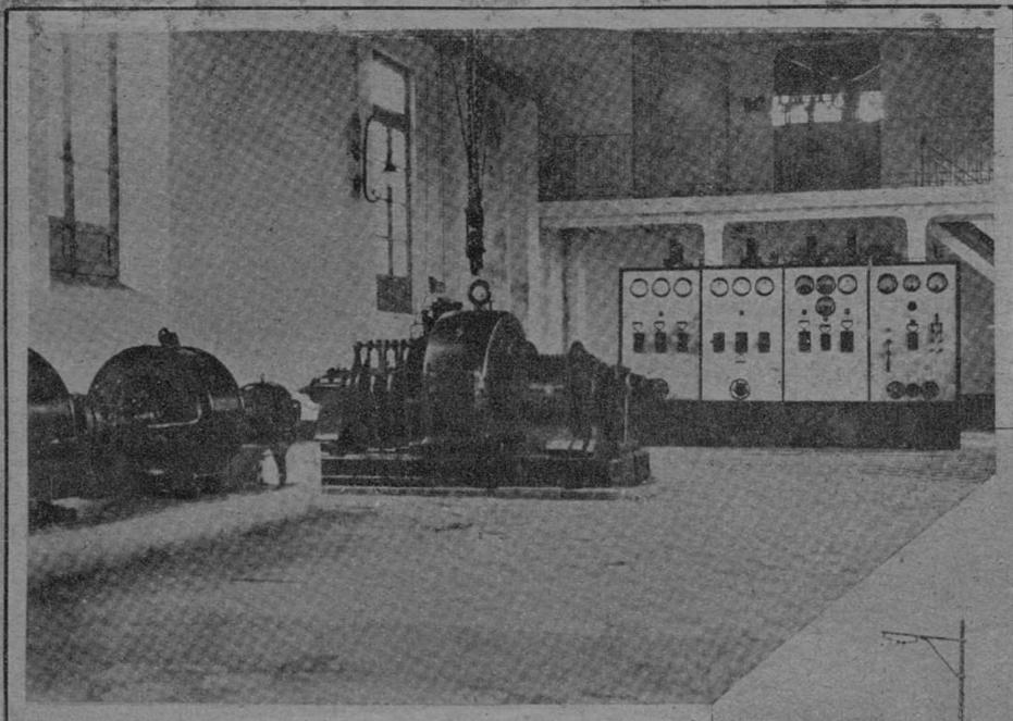
Subestación de Granada, para transformar la corriente alterna a 25.000 voltios, procedente del salto de Dúrcal o a 8.000 voltios, procedente del salto de Monachil, en corriente continua de 600 voltios. Tiene 1.000 kw. de potencia y una batería de Acumuladores «Tudor» de 300 kw. a 600 voltios
