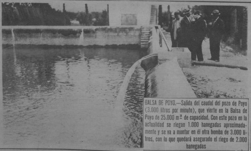
BALSA DE POYO.—Salida del caudal del pozo de Poyo (3.000 litros por minuto), que vierte en la Balsa de Poyo de 25.000 m<sup>3</sup> de capacidad. Con este pozo en la actualidad se riegan 1.000 hanegadas aproximadamente y se va a montar en él otra bomba de 3.000 litros, con lo que quedará asegurado el riego de 2.000 hanegadas
