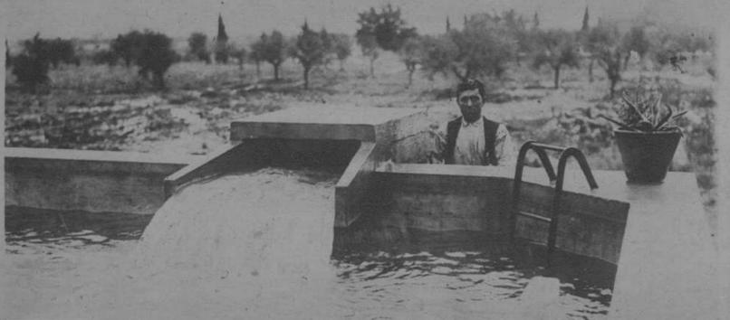
UNION ELECTRICA LEVANTINA.—Desagüe del pozo de 6.000 litros por minuto de caudal a la balsa, en Alcudia de Crespins
