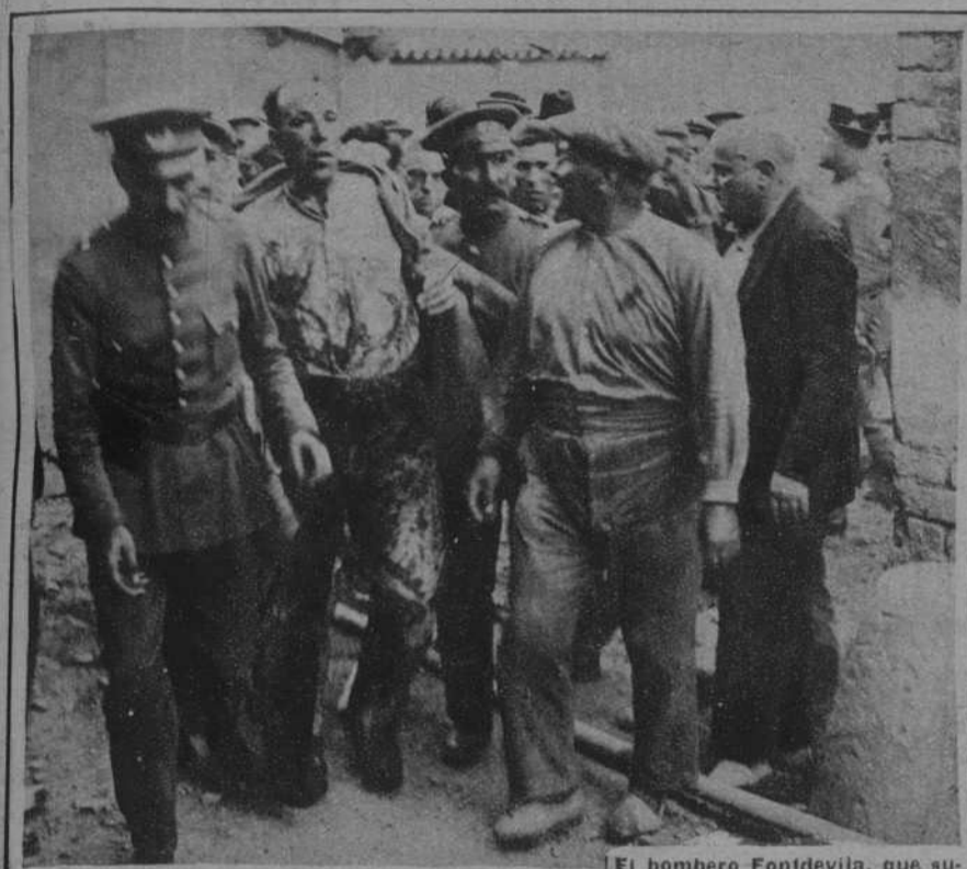
El bombero Fontdevila, que sufrió una caída desde una altura de 14 metros, en los trabajos de extinción (Fots. Casals)
