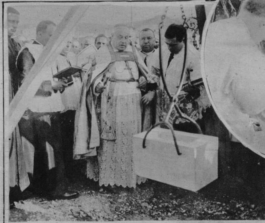
Colocacion de la primera piedra
