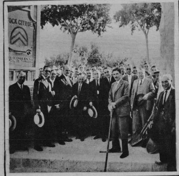
El alcalde señor Barado inaugurando las obras
