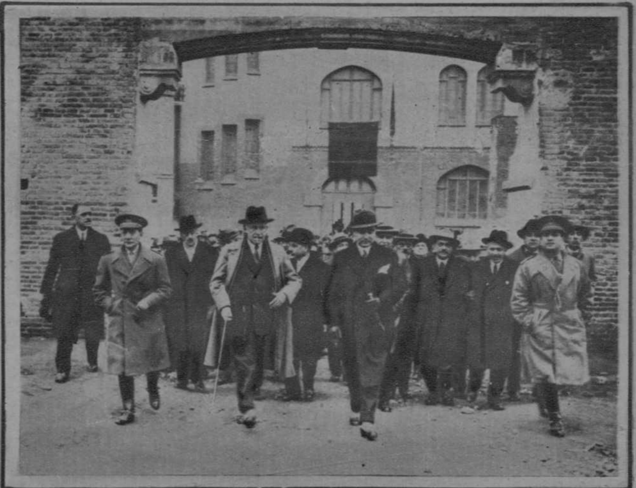
En las obras del nuevo Mercado
