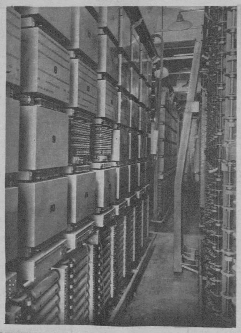
Estos registradores son los aparatos que hacen la vez de telefonistas y que recogen las llamadas de los abonados para darles los números que solicitan.
