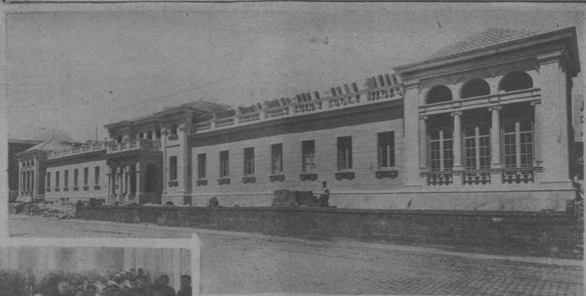
BARCELONA.—Edificio construido para enfermería del clero en el Seminario mayor de Las Cortes. (Fot. Folcra).
