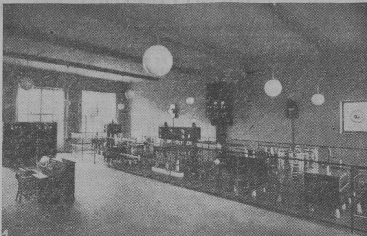
Sala de transmisión de la gran emisora de Praga, instalada por la casa Standard Eléctrica
