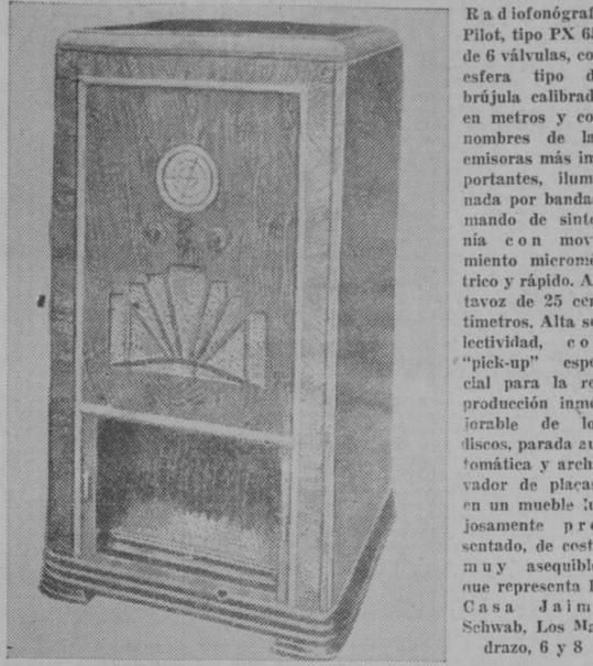
Radiofonógrafo Pilot, tipo PX 65, de 6 válvulas, con esfera tipo de brújula calibrada en metros y con nombres de las emisoras más importantes, iluminada por bandas, mando de sintonía con movimiento micrométrico y rápido. Altavoz de 25 centímetros. Alta selectividad, con "pick-up" especial para la reproducción inmejorable de los discos, parada automática y archivador de placas, en un mueble presentosamente presentado, de costo muy asequible, que representa la Casa Jaime Schwab, Los Madrazo, 6 y 8
