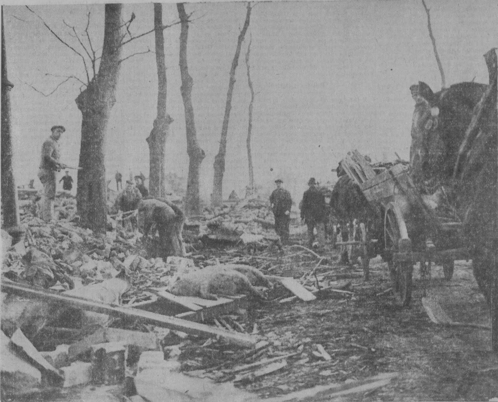
Numerosos voluntarios se aprestan al desescombro de una casa. En el centro de la figura, véñese dos cerdos, víctimas también de la explosión.
