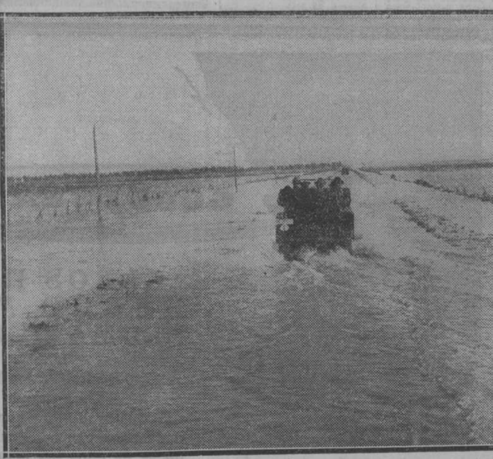
Un aspecto de la carretera de Cádiz a Sevilla, cubierta por las aguas a consecuencia de los recientes temporales. Fot. Dubols.)
