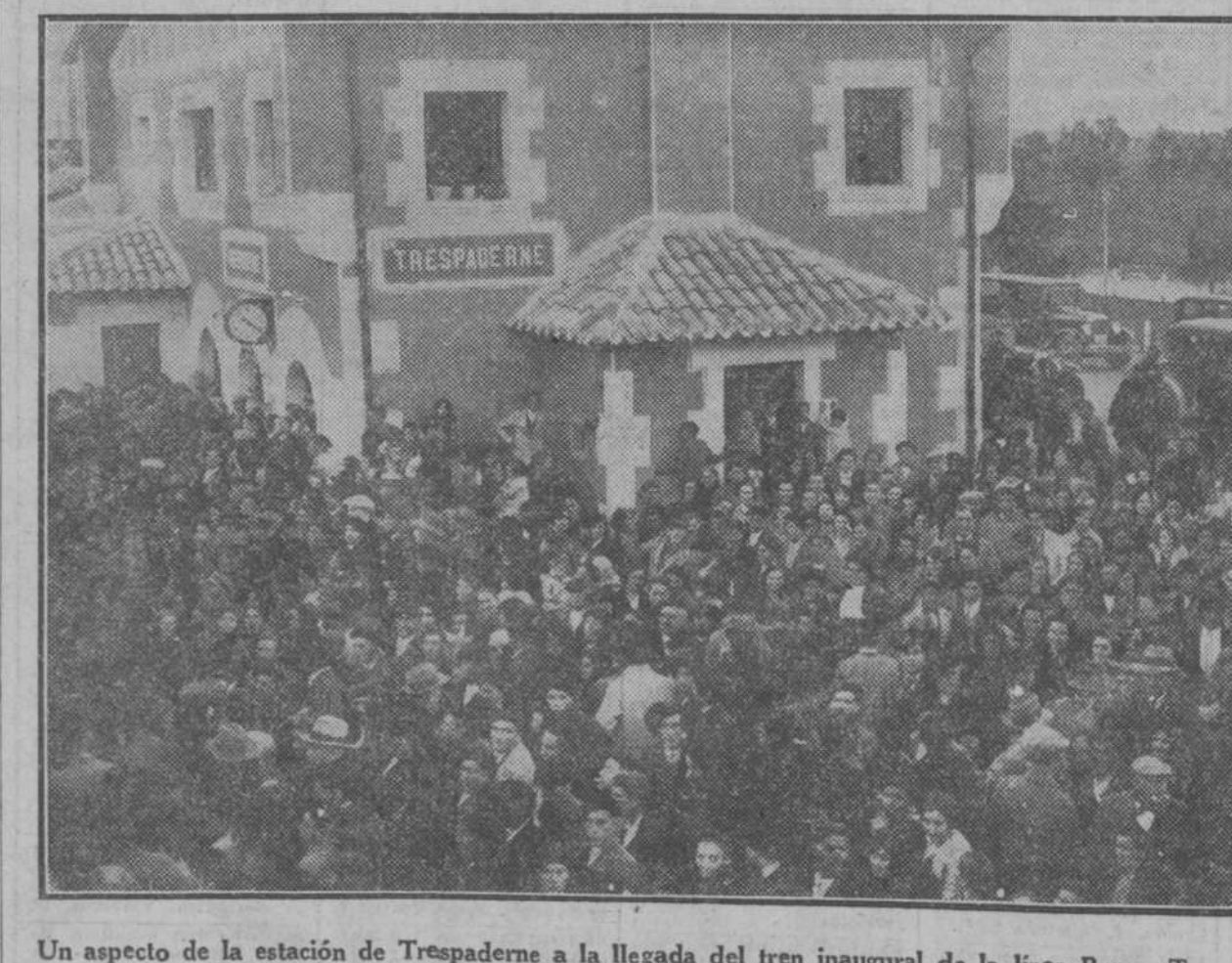
Un aspecto de la estación de Trespaderno a la llegada del tren inaugural de la línea Burgos-Trespaderno
