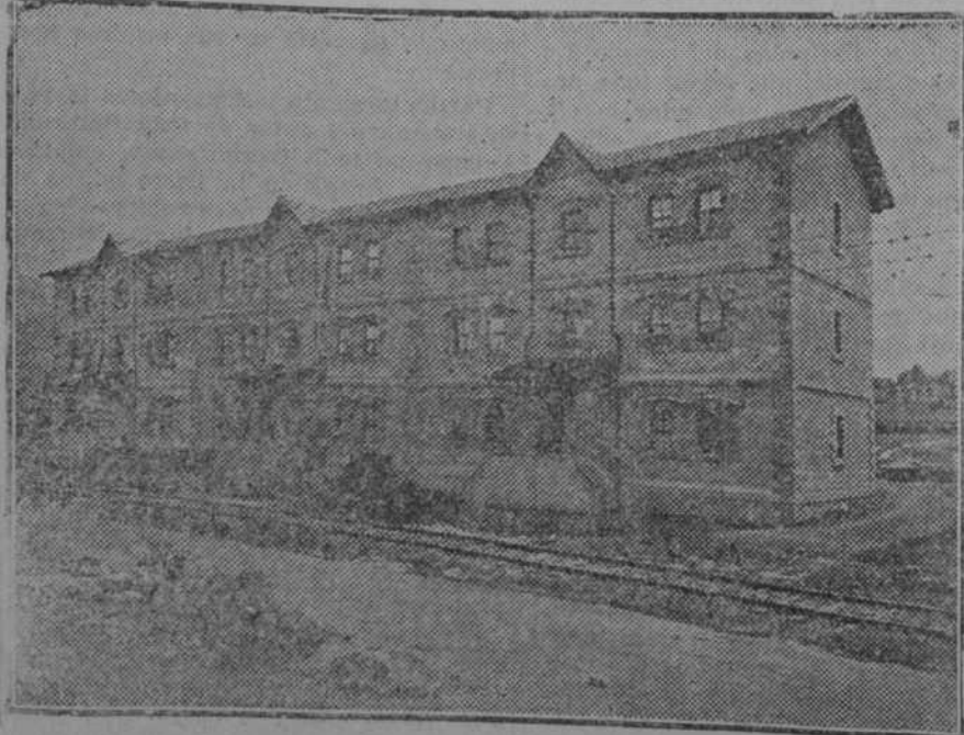
GRUPO DE 14 VIVIENDAS PARA EL PERSONAL DE LA COMPAÑIA ANONIMA BASCONIA, DE BILBAO, CONSTRUIDO CON BLOQUES DE HORMIGON
