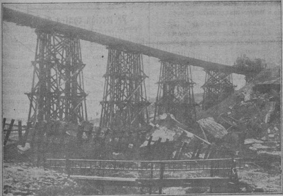
OBRA DE LOS INGENIEROS ALEMANES EN FRANCIA. PUENTE DE FERROCARRIL CONSTRUÍDO DE MADERA
