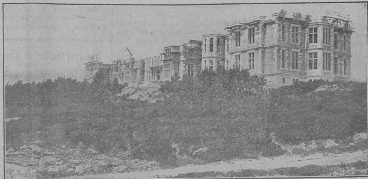
Estado actual de las obras del Palacio de la Magalanes, que la ciudad de Santander regala a S. M. el Rey.
