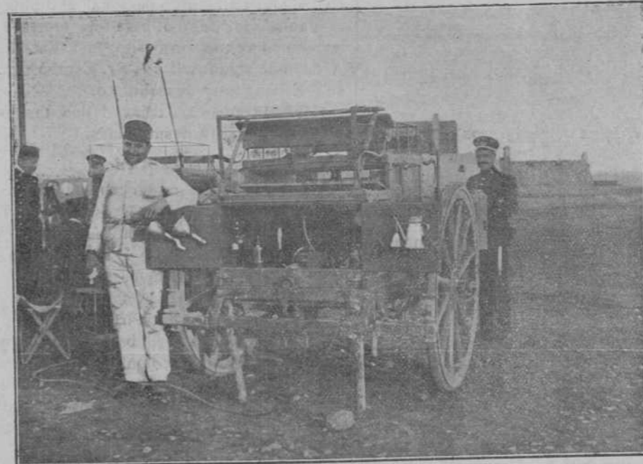
Telegrafía sin hilos: Carro-motorista Bolaños. Al pie el cable que lleva la corriente al carro-estación.
