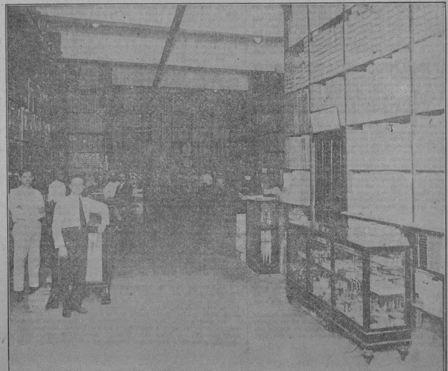
LA GRAN NAVE DEL PRIMER PISO.
