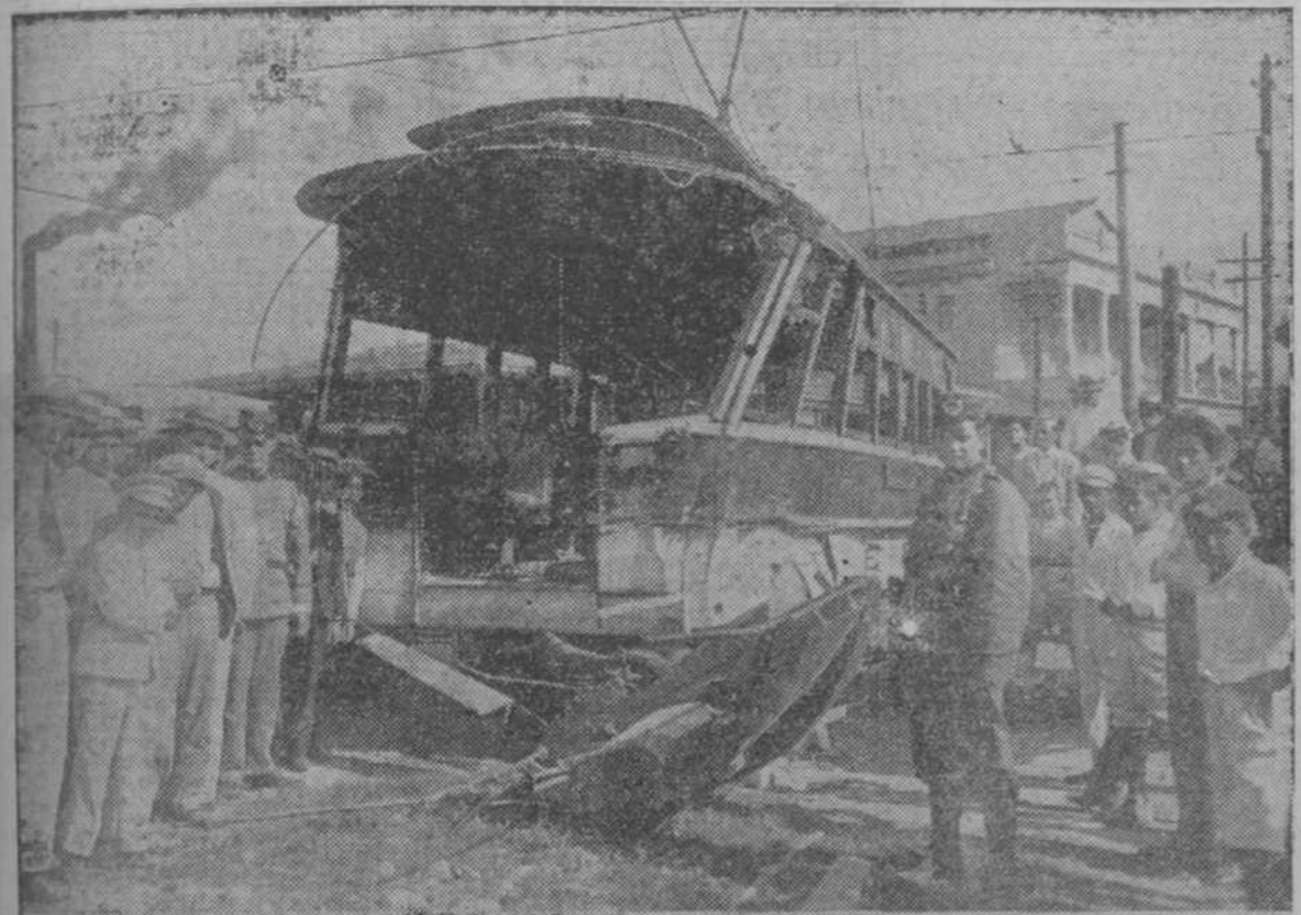
Estado en que quedó el tranvía eléctrico 379, de la línea de Luyanó-Malecón, en el solar yermo situado en Marina y Concha, después de haber chocado con el tranvía 855 de la Havana Central
